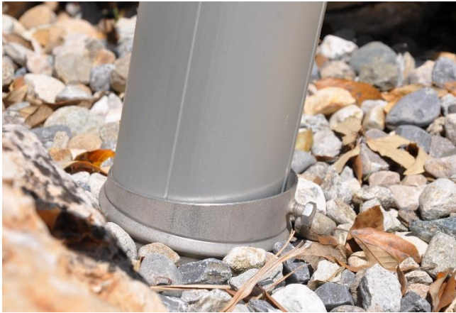
Pose avec douilles (fourreaux) scellés
