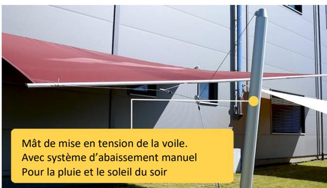
Mât de mise en tension de la voile. Avec système d'abaissement manuel Pour la pluie et le soleil du soir
