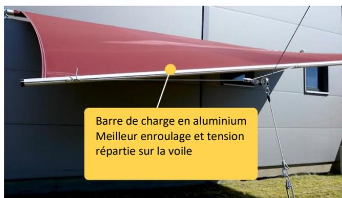
Barre de charge en aluminium Meilleur enroulage et tension répartie sur la voile
