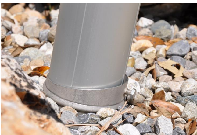
Pose avec douilles (fourreaux) scellés
