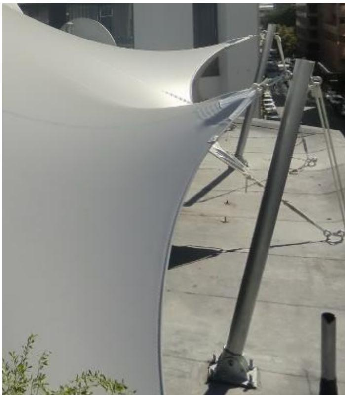
La toile Stretch pèse 720 g/m<sup>2</sup>. Elle se compose de fibres polyester élastiques à haute résistance et d'une enduction polymère. La toile dispose d'agents retardateurs d'inflammabilité, elle est totalement étanche grâce à la soudure à haute fréquence, et résistante aux UV.
