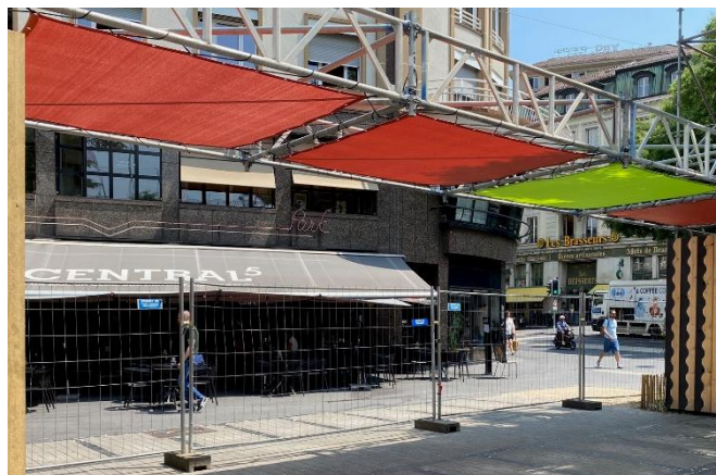
Structure échafaudage | Cèllets et élastiques zigzag
