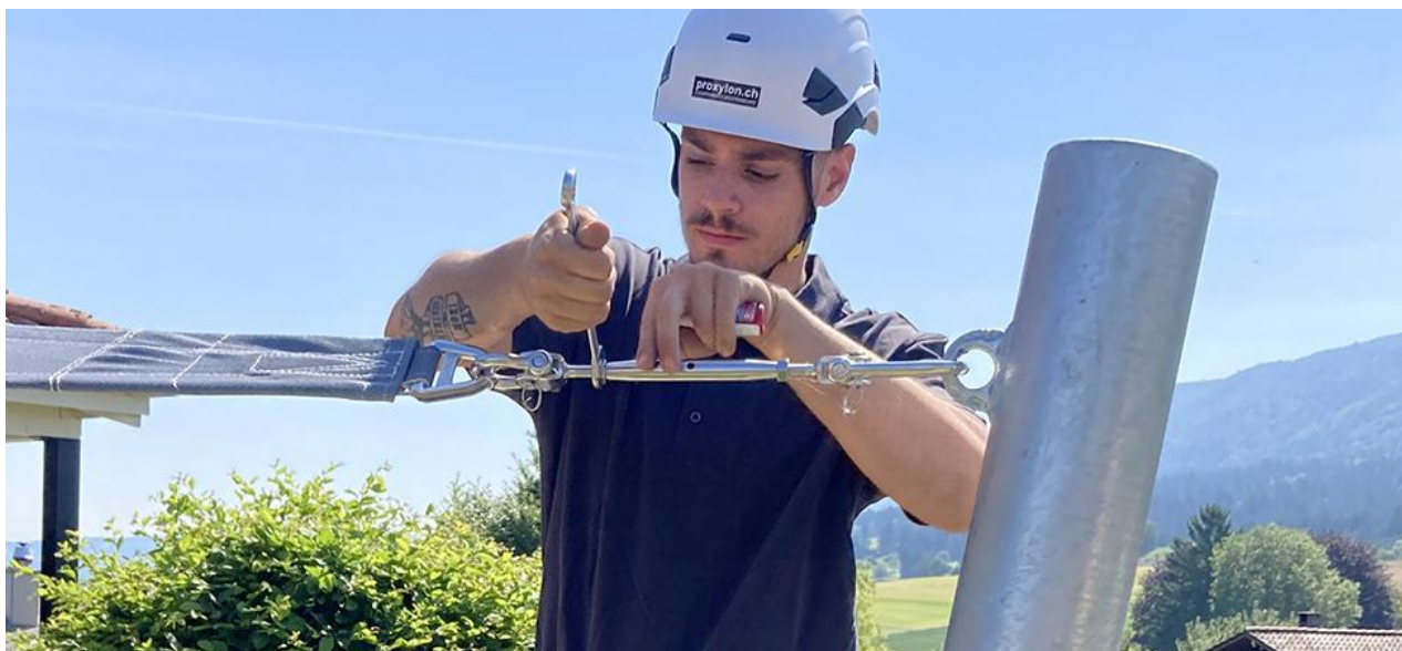
Mise en tension de la voile
